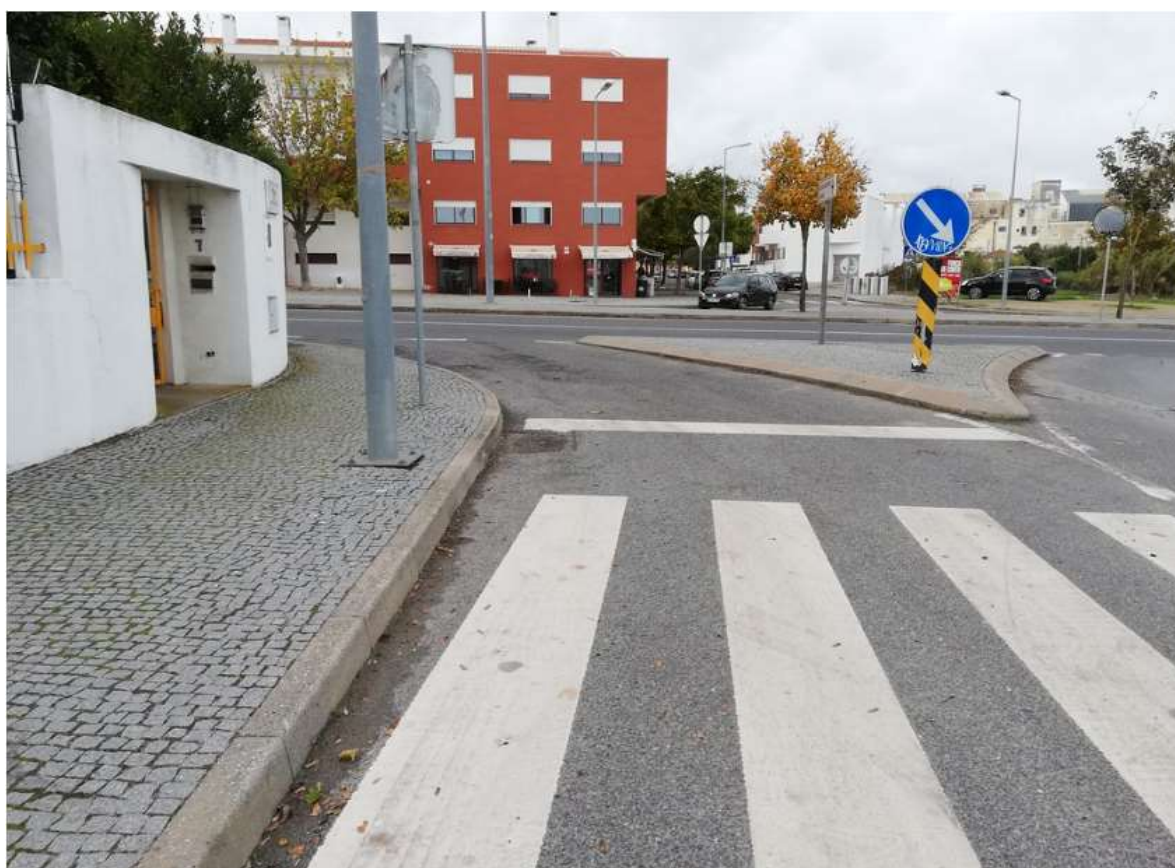
Figura 46: Um atravessamento potencialmente perigoso. Carros com origem em via rápida e ausência de visibilidade.
