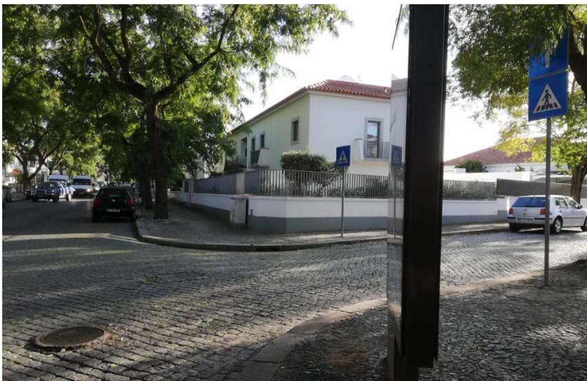
Figura 48: Passadeira com marcação deficiente e MUPI a obstaculizar a boa visibilidade entre condutores e peões.
